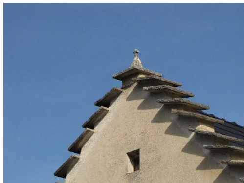
Toiture à pignons lauzés typique du Vercors, à Méaudre. Vincent Cabot (CC-BY-SA)
